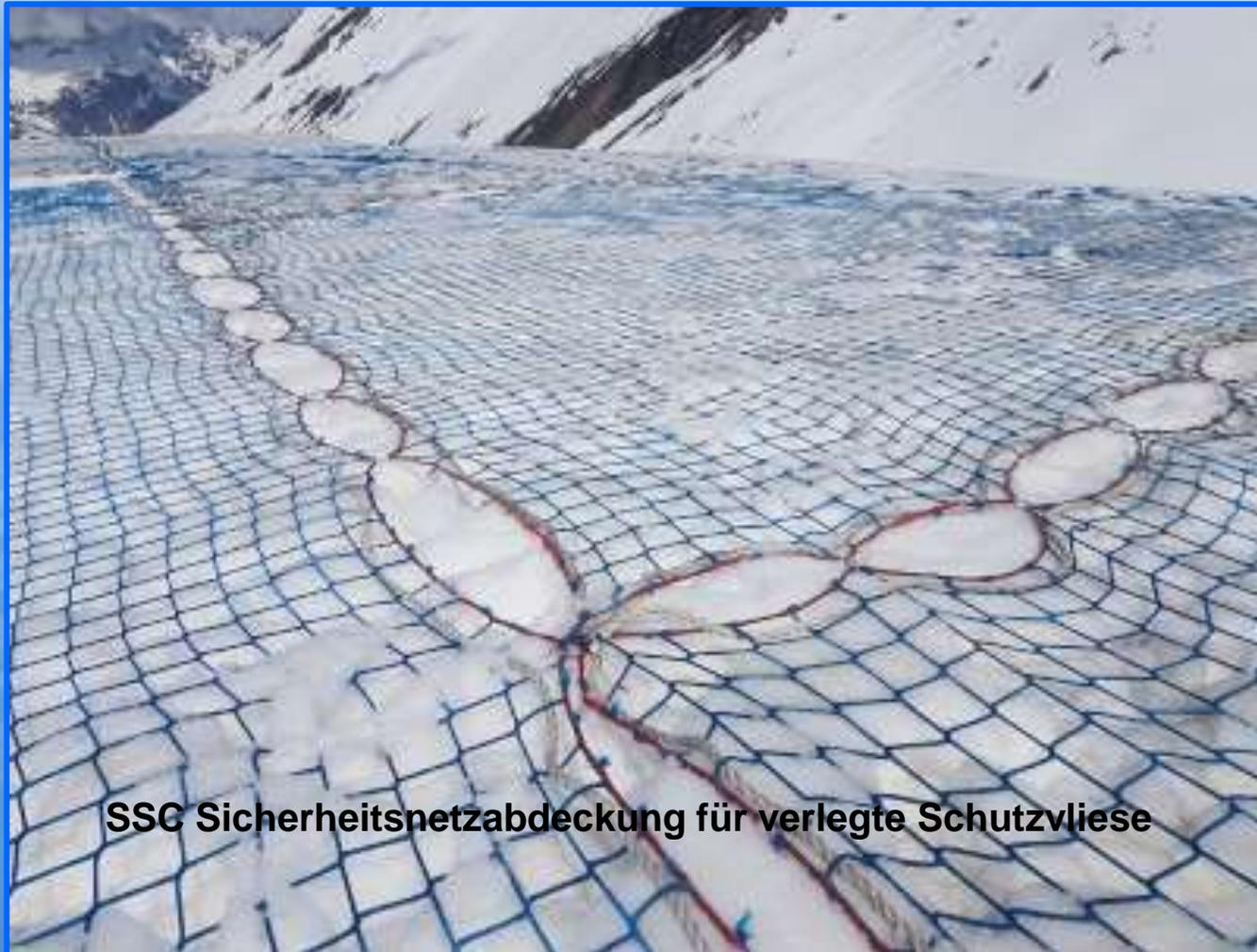
**SSC Sicherheitsnetzabdeckung für verlegte Schutzvliese**
